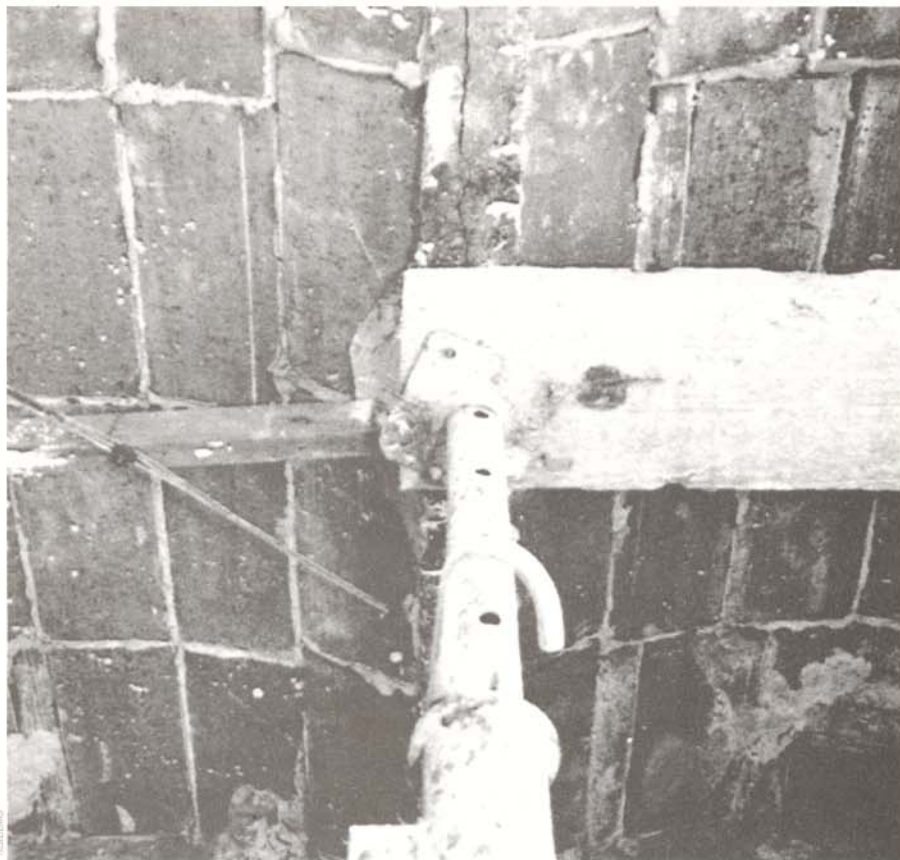
Grieta en el techo de una casa de Turó de la Peira.
