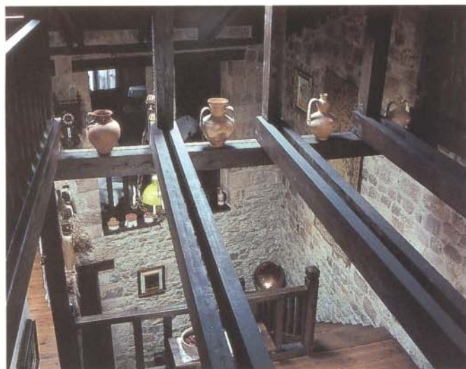
Zona de estar interior, con forjado al aire.
