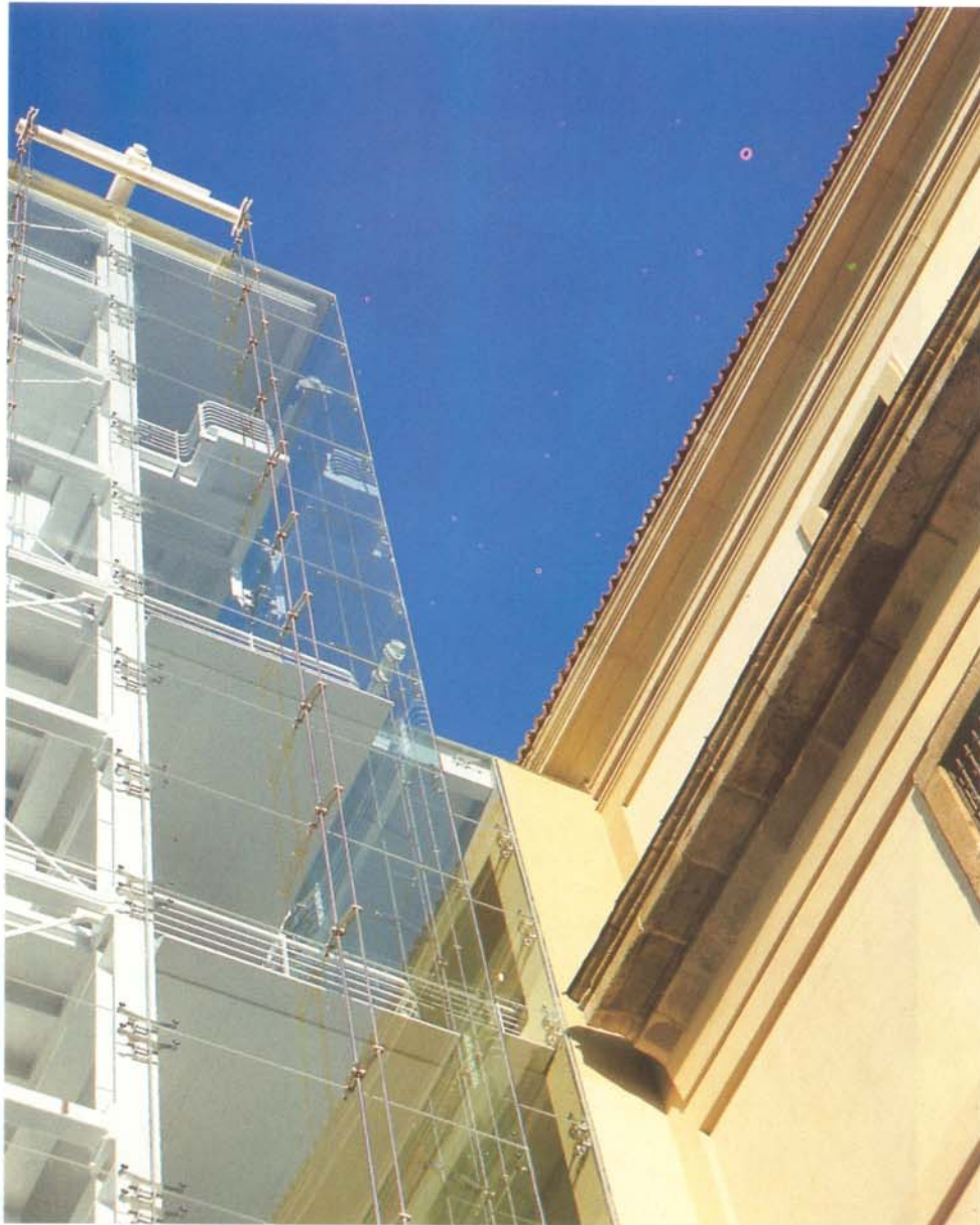
Mil millones de pesetas han costado las tres torres de visitantes.
