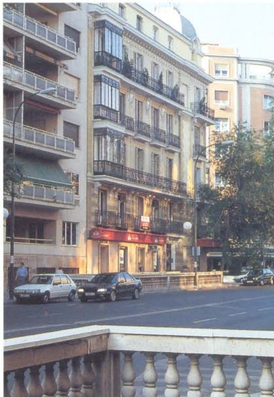
El Colegio de Madrid aconseja una inspección técnica.
