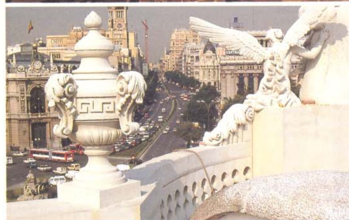
En la restauración se ha intentado respetar al máximo la originalidad del edificio.
