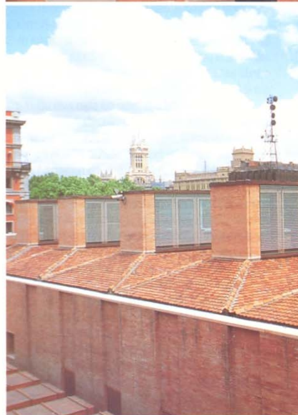
Arriba, fachada del palacio de Villahermosa. A la derecha, una imagen de los lucernarios por los que penetra la luz natural al interior del edificio.
