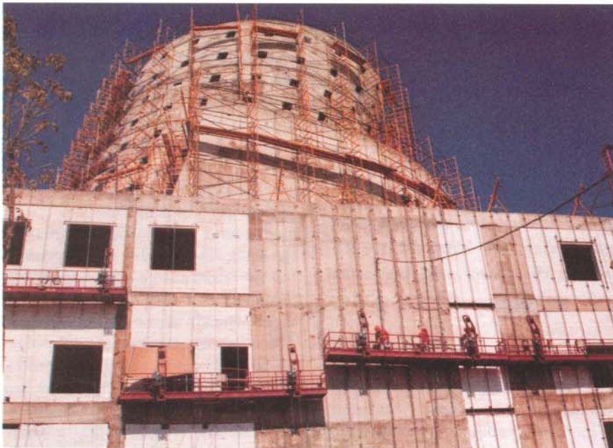
La futura ley establecerá garantías contra los defectos de construcción.
