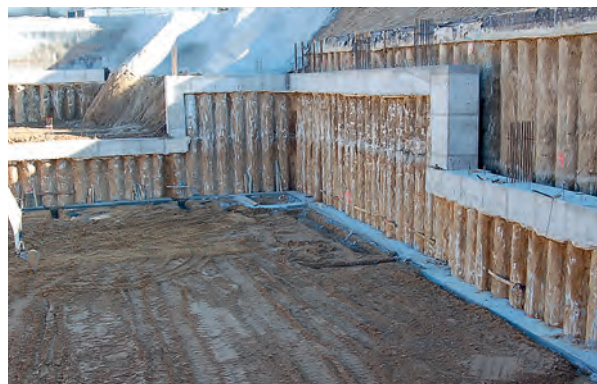
Fig. 2: ejecución pantalla de pilotes.
