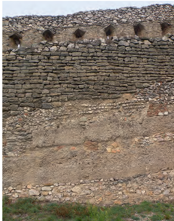
Sobre estas líneas, aspecto que presentaba el intradós de la muralla aspillerada antes de la intervención.
