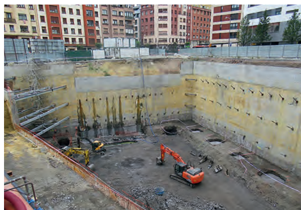
Fig. 1: ejecución pantalla continua de H.A.
