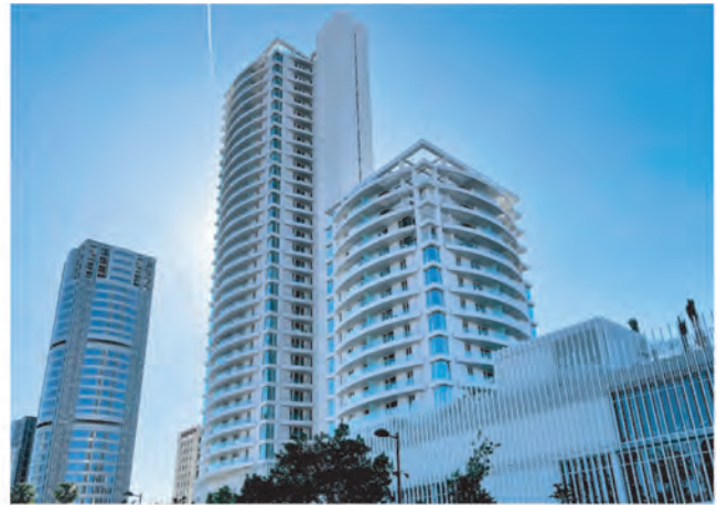
Edificio Ikon, Valencia
