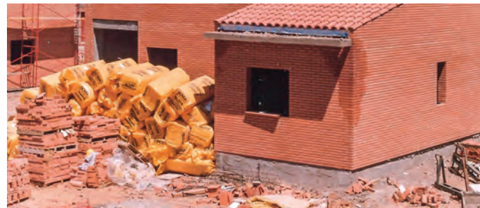
Fig. 2: acopio de planchas de aislamiento.
