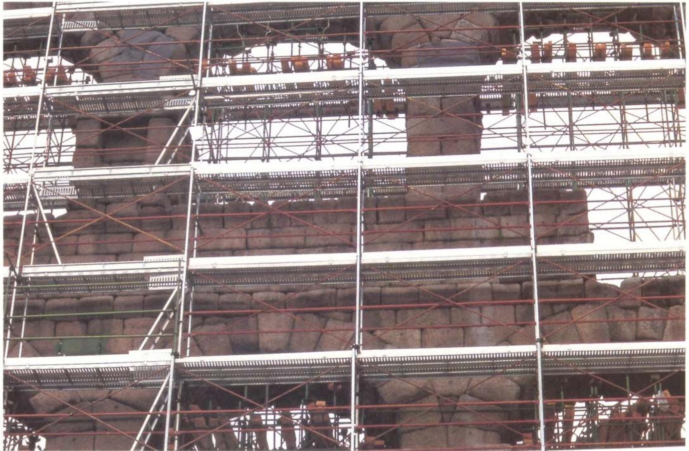
Entre las medidas urgentes se contrató el levantamiento de andamios para facilitar el estudio directo y la toma de muestras.
