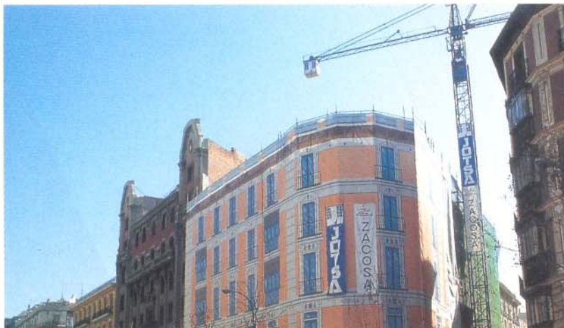
La obra de rehabilitación que se está realizando en la madrileña calle Sagasta.
