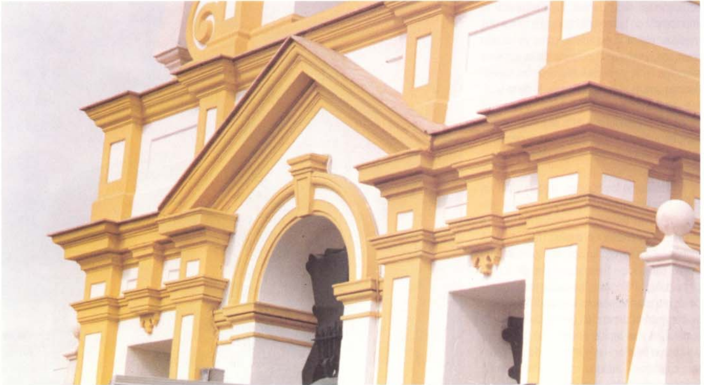
Detalle de la espadaña con los tres vanos con campanas que repiten el esquema inferior de arco y dintel.
