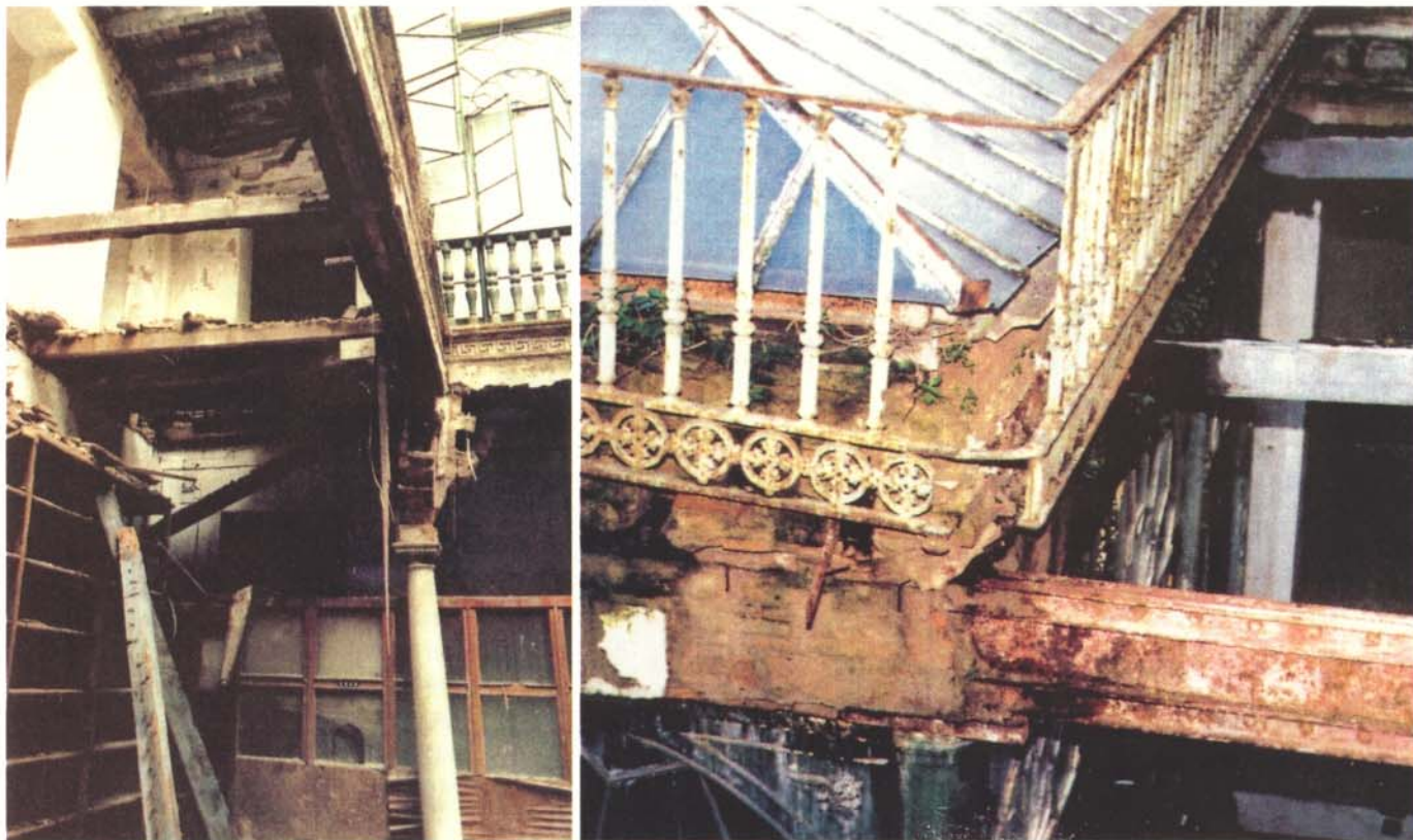
Iniciadas las obras se colocaron urgentemente apeos de seguridad ante la situación de extremo peligro.
