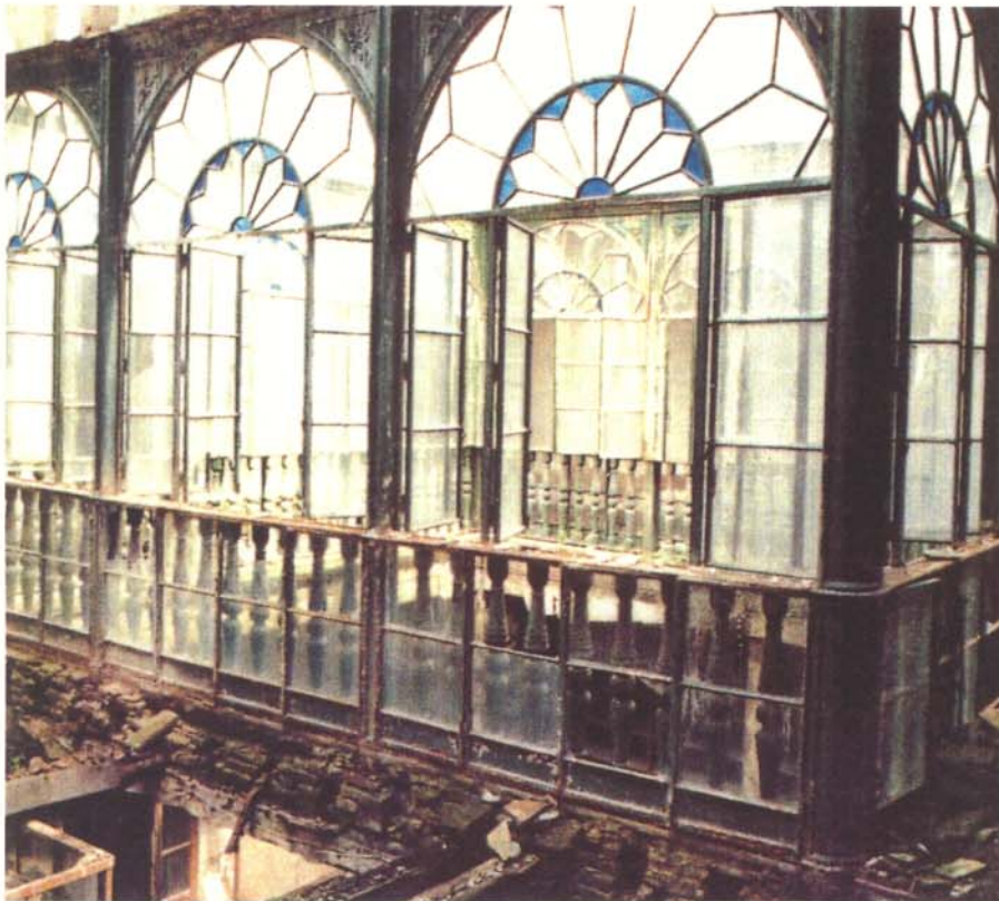
Vista de la bella balaustrada de hierro fundido del patio central.
