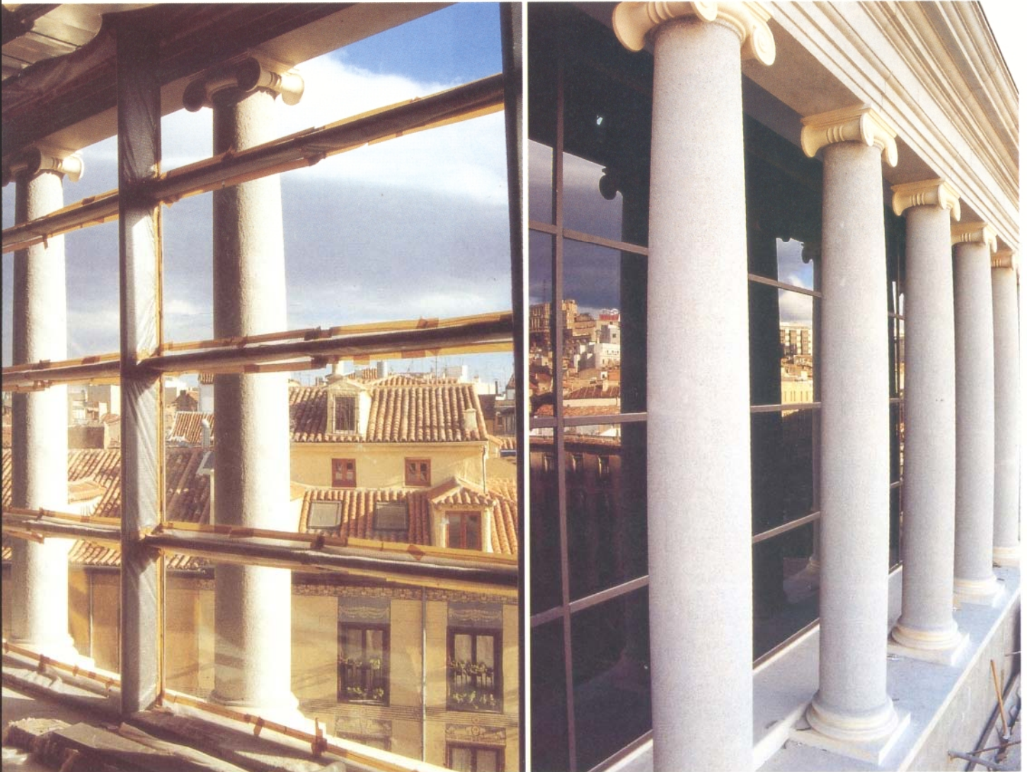
A la izquierda, un detalle de la nueva cubierta metálica. Sobre estas líneas, interior y exterior de la original columnata añadida.
