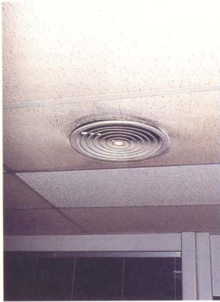
Es preciso revisar las conducciones de aire.
