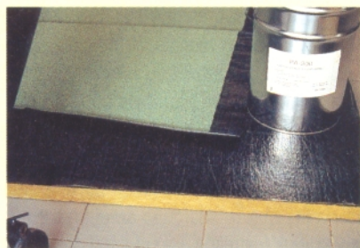
Nueva cubierta de estructura laminar.
