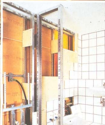
La materia prima es el cristal de yeso. Los tabiques Knauf con estructura metálica pueden recibir todo tipo de revestimientos.
