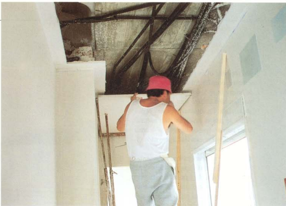
Colocación de una placa de yeso.
