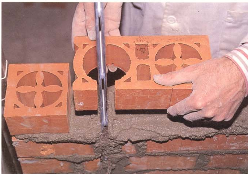
Proceso de ensamblaje del ladriflor todomuro.
