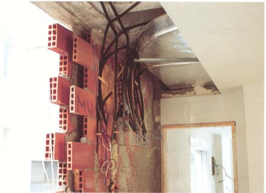
El revestimiento debe aplicarse cuando el edificio esté asentado.
