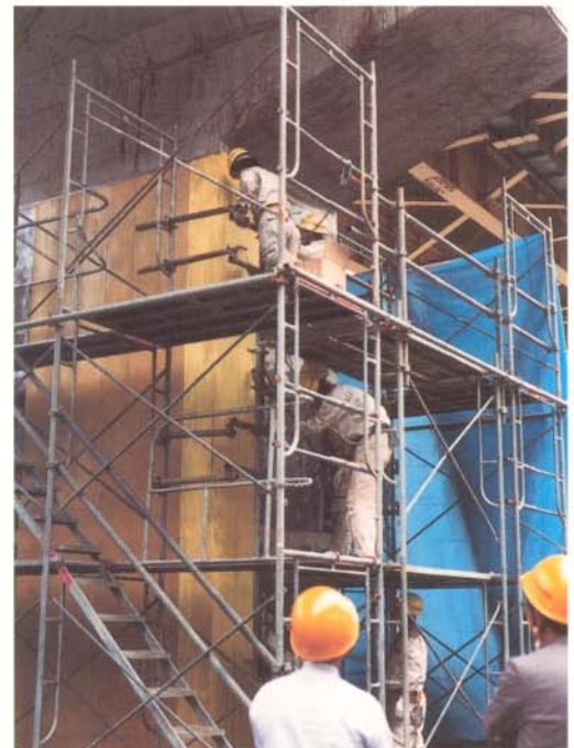
Colocación del vendaje sobre hormigón.
