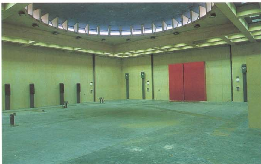
Vista parcial de la Sala. Al fondo, puerta corredera de 40 Tm.
