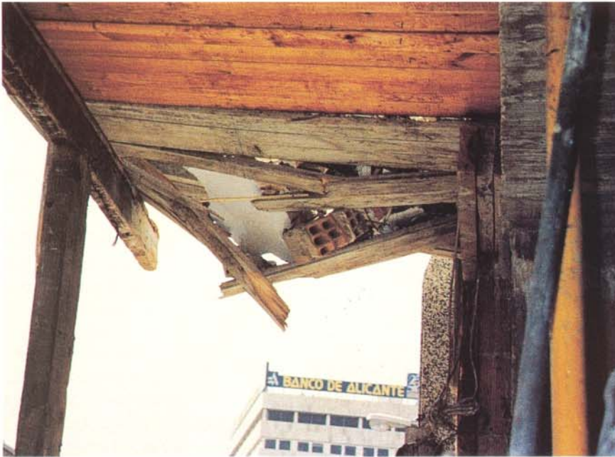
Fig. 4. La bandeja debe ser capaz de retener el objeto sin ser atravesada por él.
