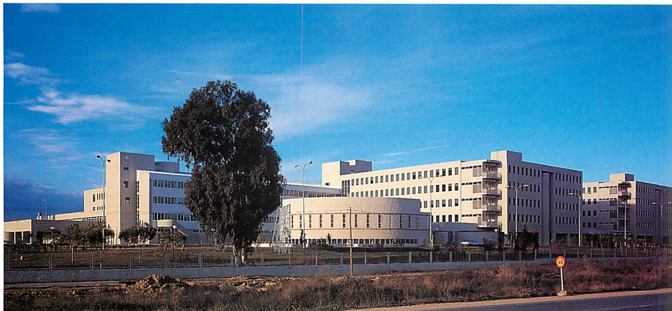
El hospital Juan Ramón Jiménez, de Huelva, es un edificio bajo y extenso, organizado sobre una malla birreticular.
