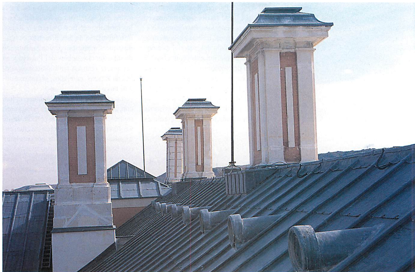
Los trabajos de recuperación han afectado también a las beatas de ventilación, a las chimeneas y a los lucernarios.
