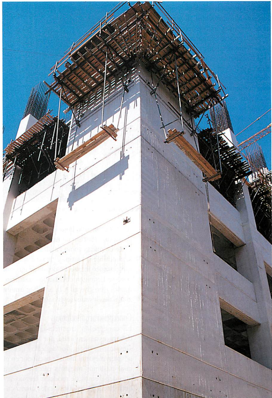
Pantalla antisísmica en “L” situada en la periferia estructural.
