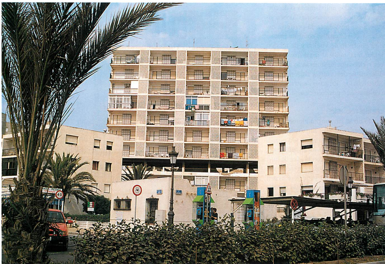
Edificio con entreplanta corta y diáfana con previsión de elementos estructurales antisísmicos.
