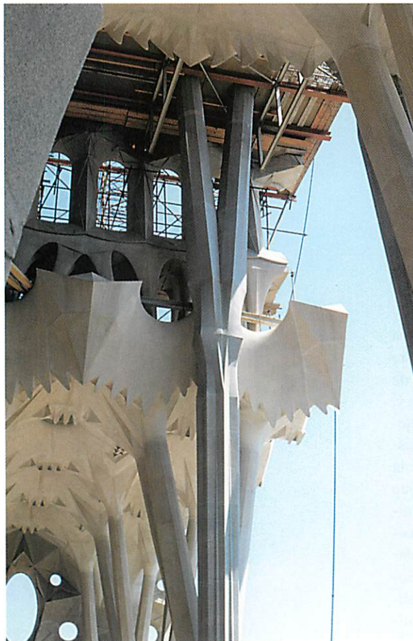
Columnas que soportan las bóvedas.
