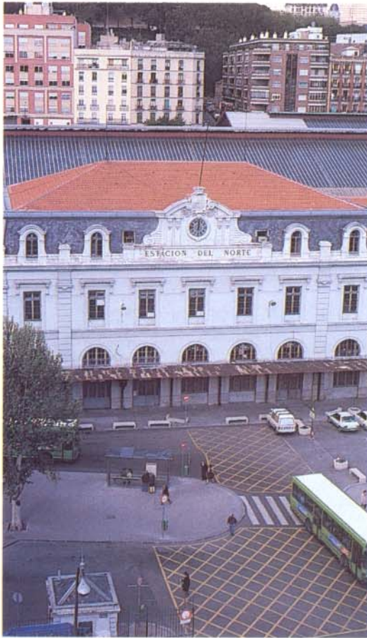
Se dispone de un espacio poco habitual en las edificaciones actuales.
