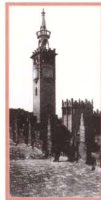
El propietario de la fábrica, Casimir Casaramona, posaba en la cubierta en 1913.
