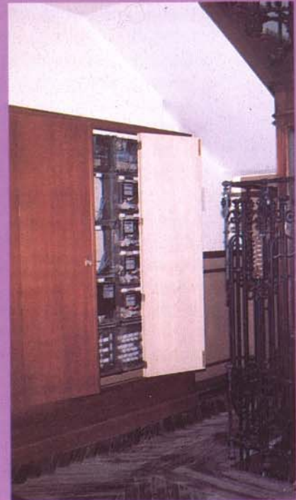
Las instalaciones de enlace unen la caja general con las interiores.
