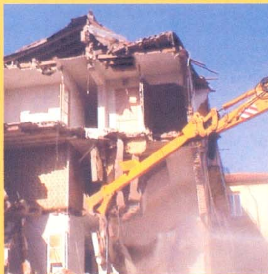
Demolición &amp; Reciclaje
