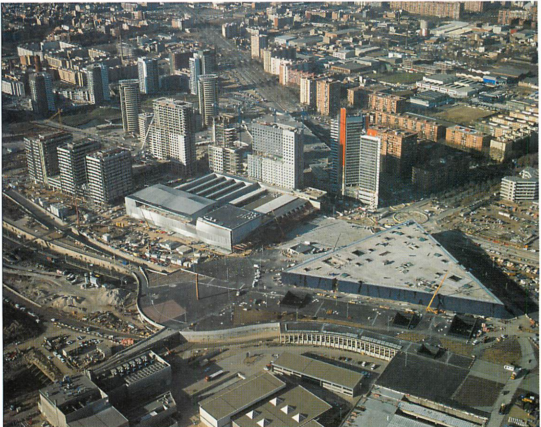
Obras de construcción del emblemático edificio Fórum de planta triangular.
