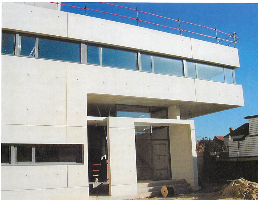
Estructura vista ejecutada con hormigón autocompactable.
