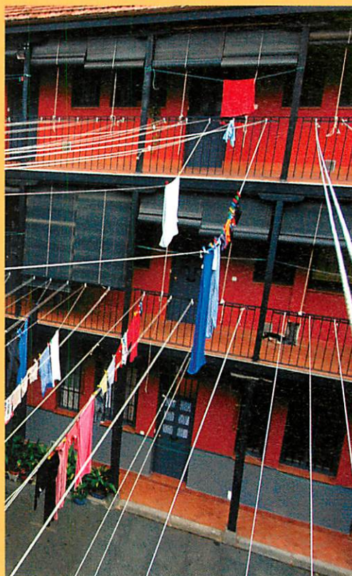
La rehabilitación ha permitido ampliar las minúsculas viviendas existentes e, incluso, instalar un ascensor en el hueco dejado por el baño común.
