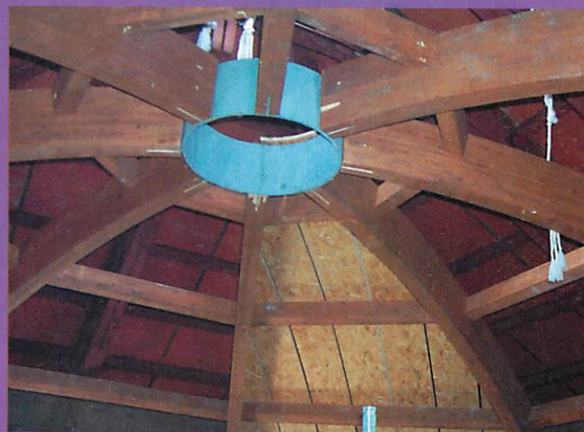
Gran parte de las cubiertas se han sustituido por una estructura de madera laminada formada por cerchas, arcos y correas.
