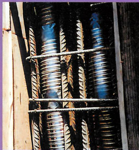
Vista desde la parte superior del encofrado, donde se observa la alta densidad de armadura.
