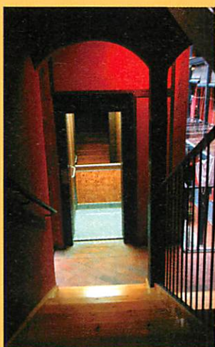
La rehabilitación ha permitido ampliar las minúsculas viviendas existentes e, incluso, instalar un ascensor en el hueco dejado por el baño común.
