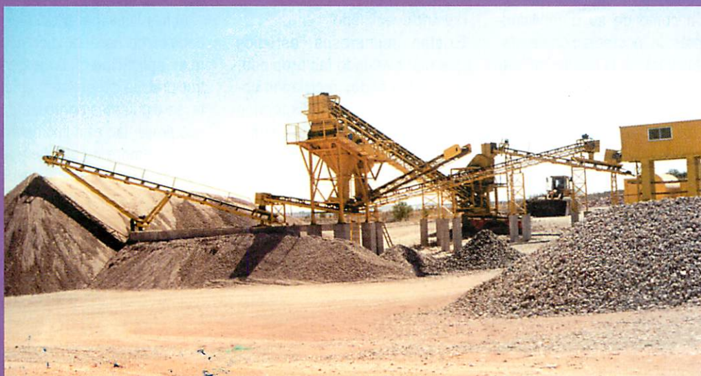
Fotografía 5: vista general de planta de reciclado de escombros.
