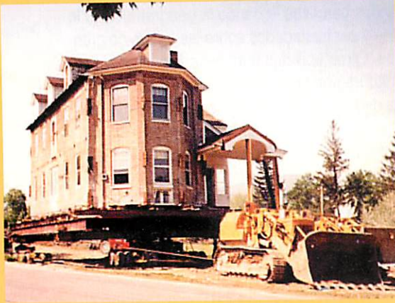
Las palas articuladas también sirven de vehículo de arrastre. Vemos parte del traslado de la Corbin House, de 275 toneladas.
