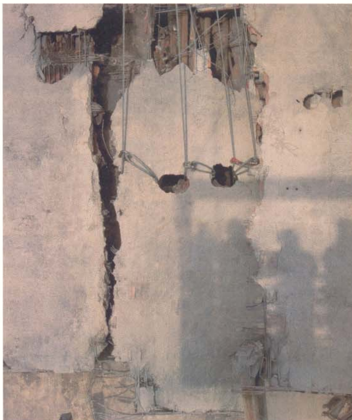
Detalle que muestra el enganche de las piezas colgadas.
