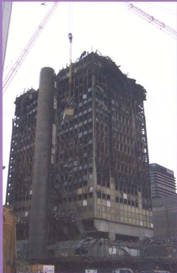
La situación del edificio tras el incendio contrasta con la imagen que ofrece a los tres meses del comienzo de los trabajos de demolición, que están siendo realizados en ejecución sustitutoria por el Departamento de Control de la Edificación del Ayuntamiento de Madrid.
