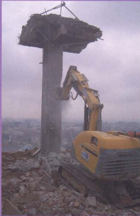
Rotura mediante robot de soporte y, abajo, transporte de soporte y capitel.
